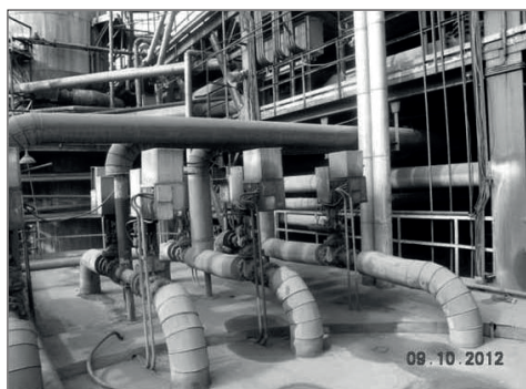
Slika 9. Glinica Zvornik (2012. godine), linije s elektrohidrauličnim linearnim pogonima i servomotorima
