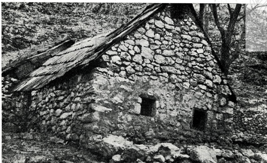
60) Dvocelna tahtara, malterisana iznutra i samo djelomično izvana. Prozori su naknadno probijeni
