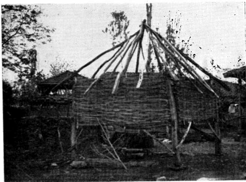
Abb. 4. Tronj im Bau im Dorfe Bardovci bei Skoplje (1937).
