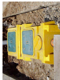
Izgled separatora ulja i naftnih derivata ugrađenog u zemlju (paralelnim spajanjem više separatora je moguće dobiti željeni kapacitet)
