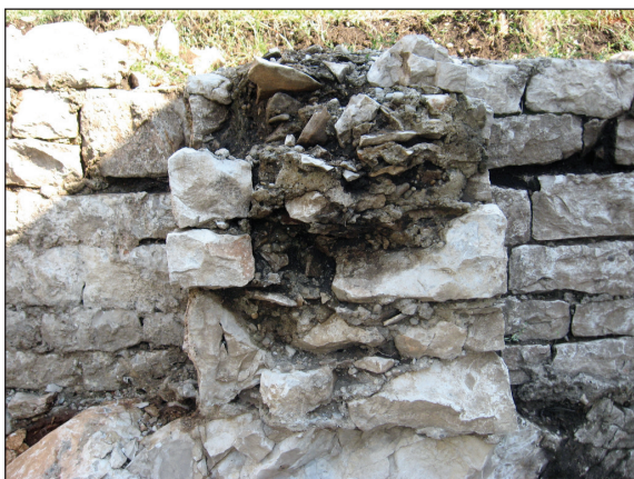
Sl. 5. Presjek pregradnog zida B2
