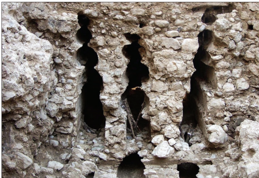
Sl. 6. Masivni željezni klinovi drvenoga kasnosrednjovjekovnoga mosta, preostali u šuplinama zidova
